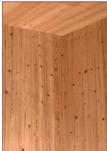
Brettsperrholz-Wände mit Exklusiv-Oberfläche in Altholz
