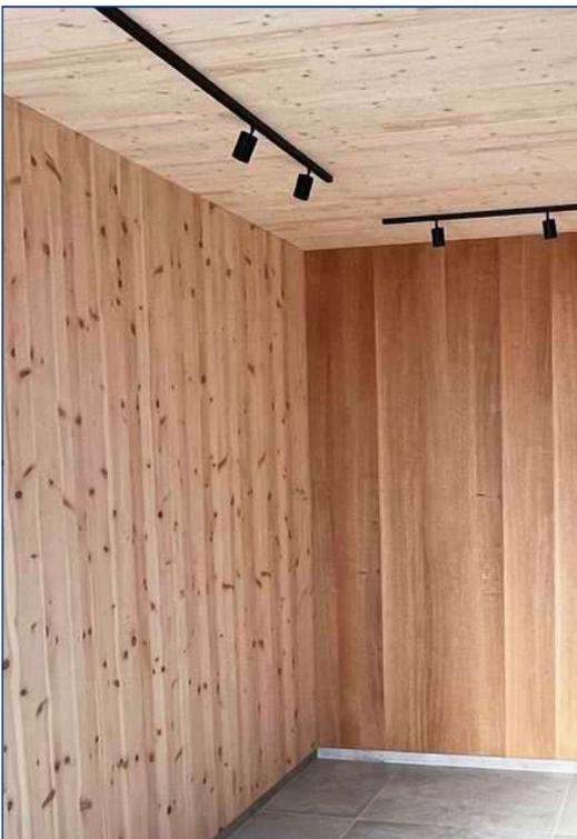
FHS produziert das **Brettsperrholz im eigenen Werk** in Tschechien, vom Baumstamm bis zum Abbund der fertigen Wand- und Deckenelemente, **in allen Qualitäten** von „Nicht-Sicht“ bis „Exklusiv“. Für Kunden, denen keine eigene Planungsabteilung für den Brettsperrholz-Bau zur Verfügung steht, kann die **Werkplanung** übernommen werden.
